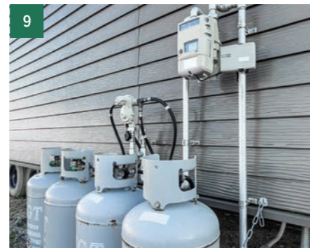
9 ガスボンベが簡易に着脱できること。
