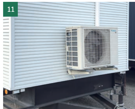
11 エアコン等の室外機がトレーラーハウスに積載されていること。
