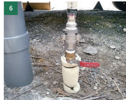
6 給水管の接続方法が工具無しで着脱できる方式であること。
