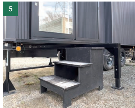
5 「階段」「デッキ」が独立した構造体であり、トレーラーハウスの移動に支障がない規模・構造であること。
